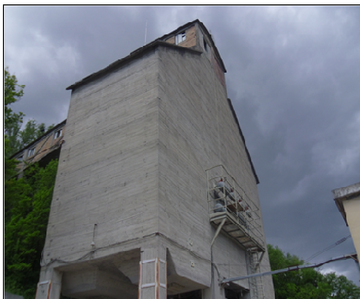
Foto 2.2: Il silos e la tramoggia di scarico del frantoio.
